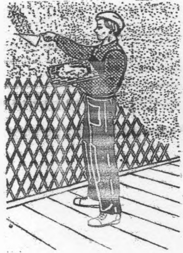
Рис. 2. Накидання штукатурного розчину кельмою з сокола на стіну
