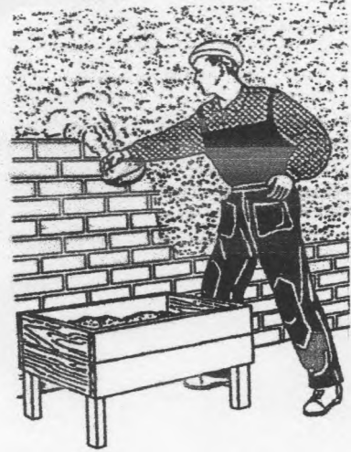
Рис. 4. Накидання штукатурного розчину ковшем
